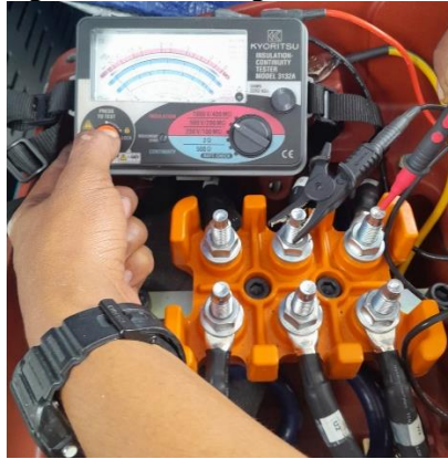
Gambar 6. Megger terhadap motor compressor kondis baik (Sumber : Dokumen Pribadi)
