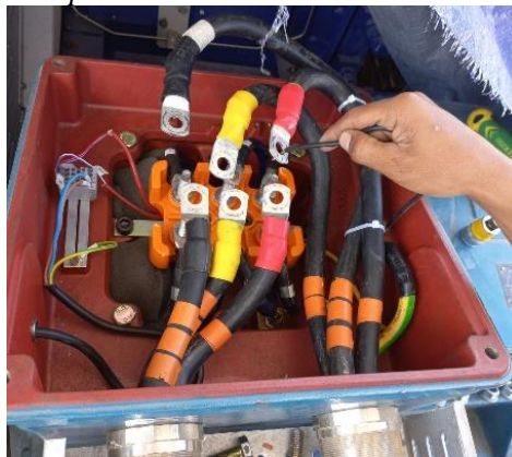
Gambar 11. Pemasangan kabel pada motor compressor (Sumber : Dokumen Pribadi)
