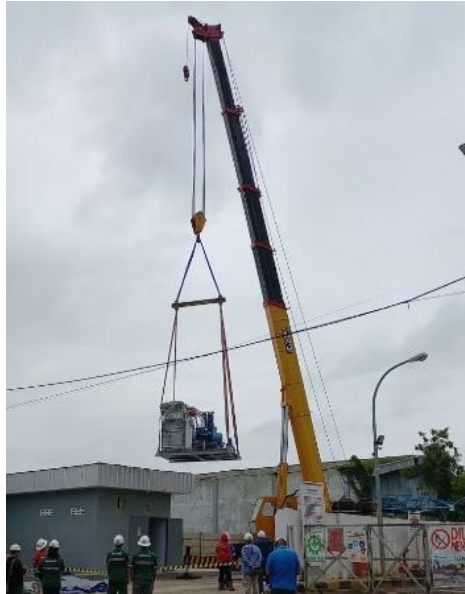
Gambar 4. Proses pengangkatan kompresor ke atas pondasi menggunakan crane 50 ton (Sumber : Dokumen Pribadi)
