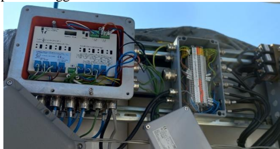
Gambar 10. Pemasangan kabel kontrol ke sistem komunikasi modbus (Sumber : Dokumen Pribadi)
