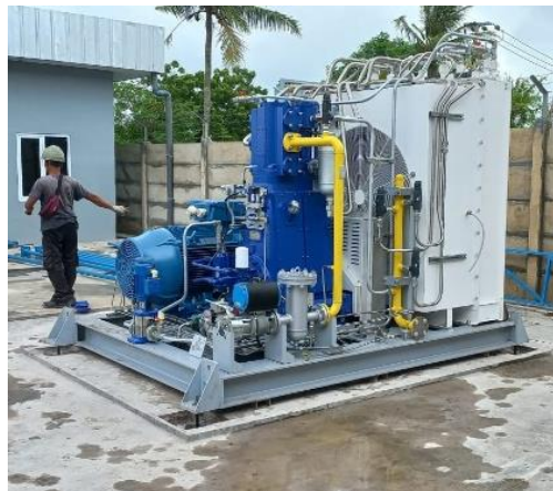
Gambar 5. Terpasang di atas pondasi, antara pondasi dan frame diberikan celah untuk grouting . (Sumber : Dokumen Pribadi)
