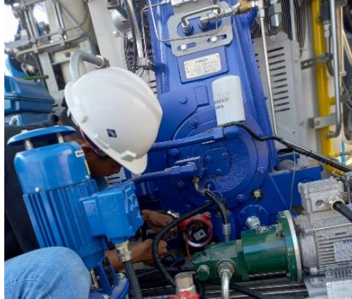
Gambar 12. Pemasangan kabel oil heater (Sumber : Dokumen Pribadi)
