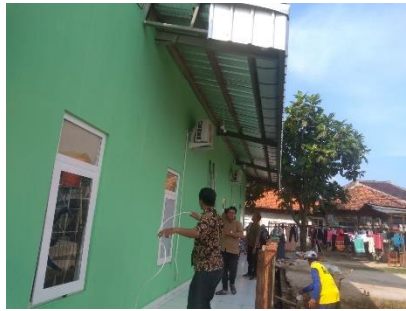
Gambar 9. Pemasangan Solar Panel Ke Ruang Pesantren
